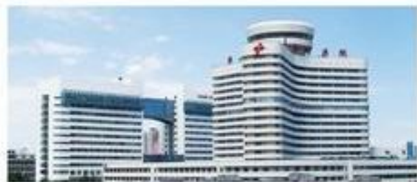
天津市第一中心医院项目 Tianjin First Central Hospital
